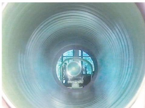
Además, el revestimiento de PUR resiste de forma constante diferentes cargas químicas y mecánicas (p. ej., aguas duras, ácidas o saladas, escombros en aguas residuales o limpieza a alta presión) y garantiza la resistencia frente a aguas residuales de cualquier tipo.
