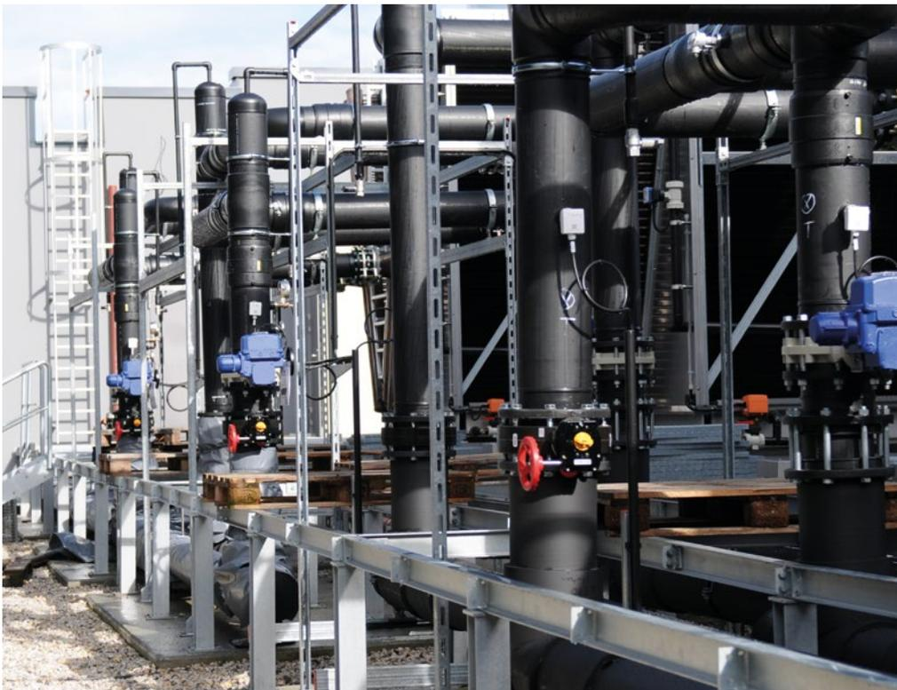
Los tubos y accesorios de PE 100-RC instalados en superficie con dimensiones  $d_a=280$  mm y SDR 17 se utilizan para la unión de las torres de refrigeración y los equipos de frío.
