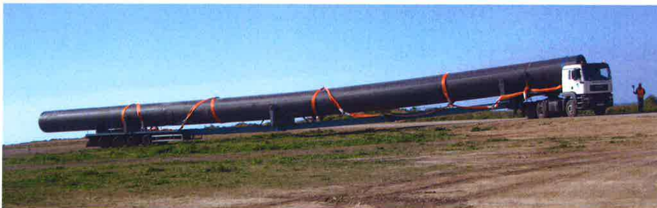
Foto 11 - Sistema de transporte novedoso en obra, tubo OD2100 em Marruecos
