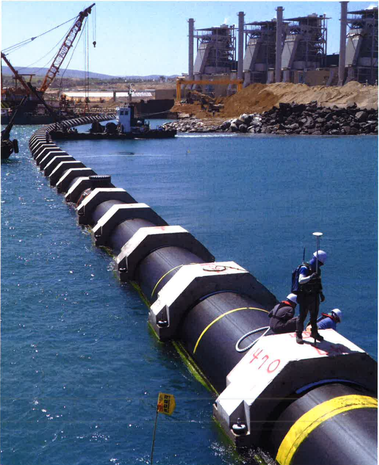
Foto 10 - Inicio hundimiento tubo OD2500, SDR26
