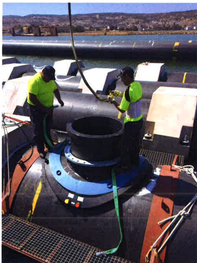
Foto 4 – Preparación del saddle para su soldadura en la obra.
