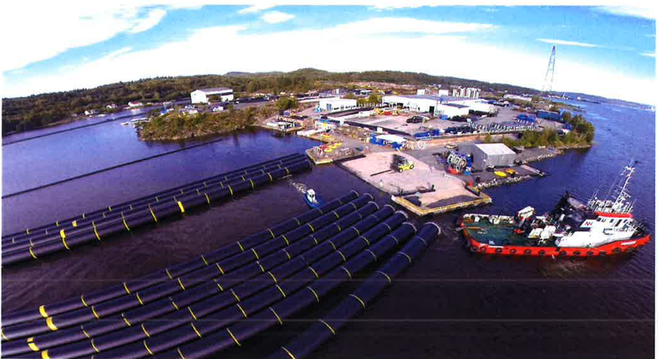
Foto 1 – Planta de Pipelife Norge en Stathelle
