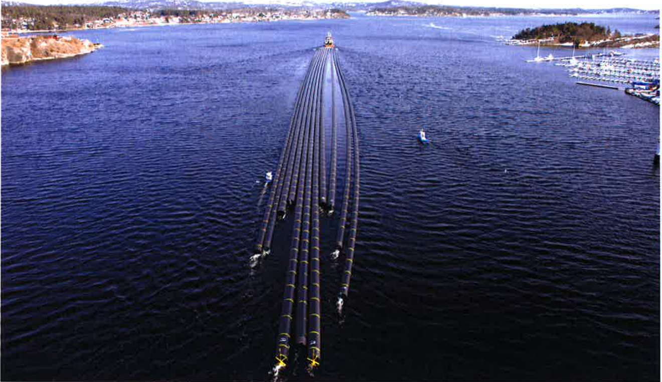
Foto 2 – Salida de 7 tramos de OD2500 mm, de 480 mts cada uno.
