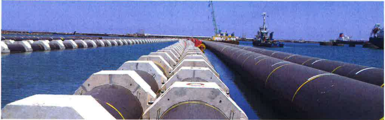
Foto 9- Algunos diseños de lastres para tuberías marinas
