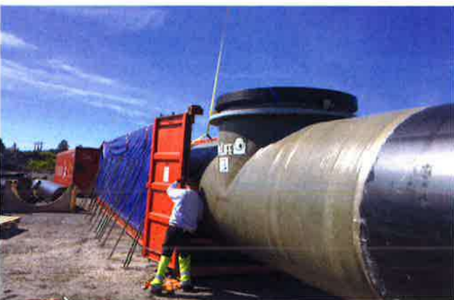
Foto 7 - Pieza en T de OD2000 mm reforzada
