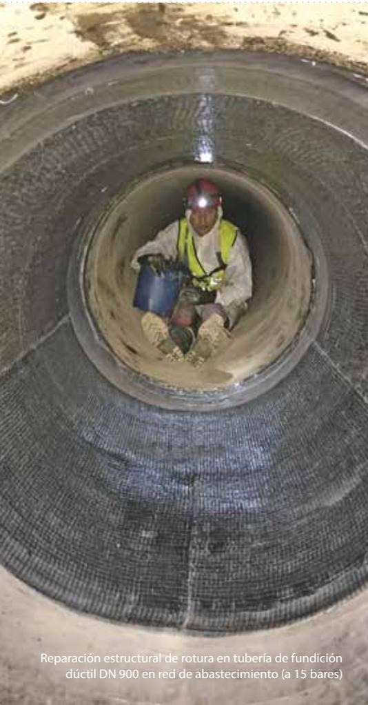
Reparación estructural de rotura en tubería de fundición dúctil DN 900 en red de abastecimiento (a 15 bares)
