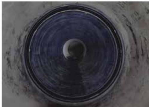
Reparación estructural interior de tubería de hormigón pretensado DN1600.
