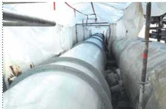
Reparación estructural interior de tubería Bonna DN2100. Sistema de refrigeración de Central térmica EDF (Francia)
