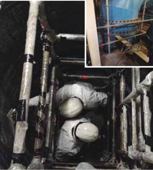
Reparación estructural interior de tubería de acero DN1800. Sistema de refrigeración Central térmica de gas EDF (Francia)
