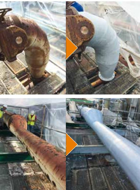
Rehabilitación y Protección contra la Corrosión de tubería de acero (DN500 a DN1000) de red de refrigeración en la Industria Química. Aplicación con tubería en funcionamiento sin interrupción del servicio.
