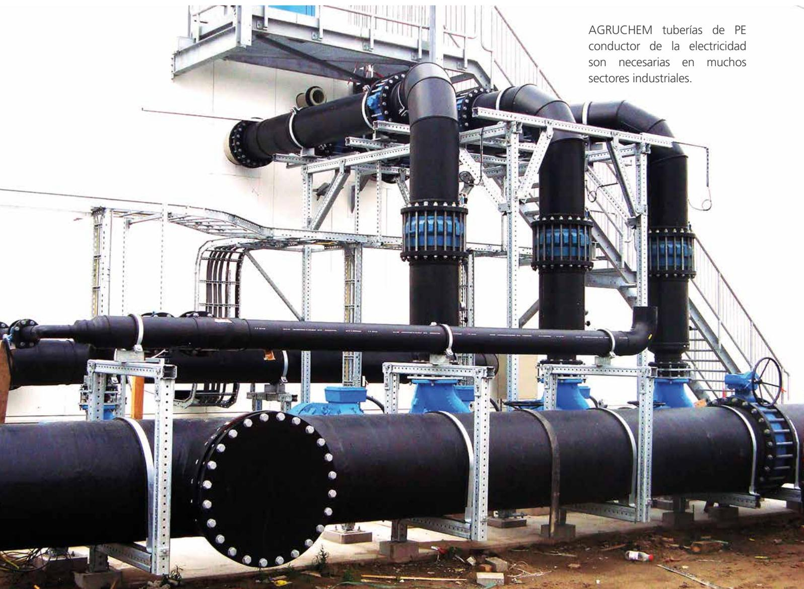
AGRUCHEM tuberías de PE conductor de la electricidad son necesarias en muchos sectores industriales.
