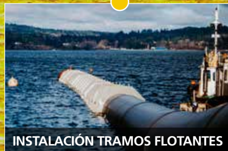
TENDIDO Y HUNDIMIENTO
