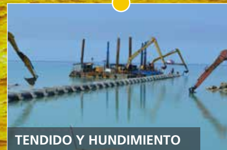
INSTALACIÓN TRAMOS FLOTANTES
