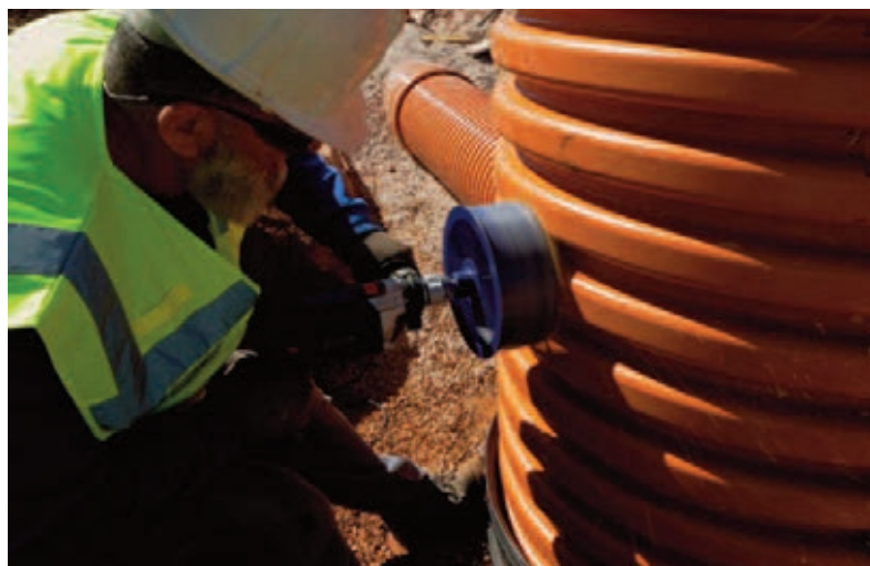
Realización de una acometida con corona de corte
