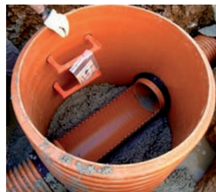
Acabado interior de un pozo a 180°
