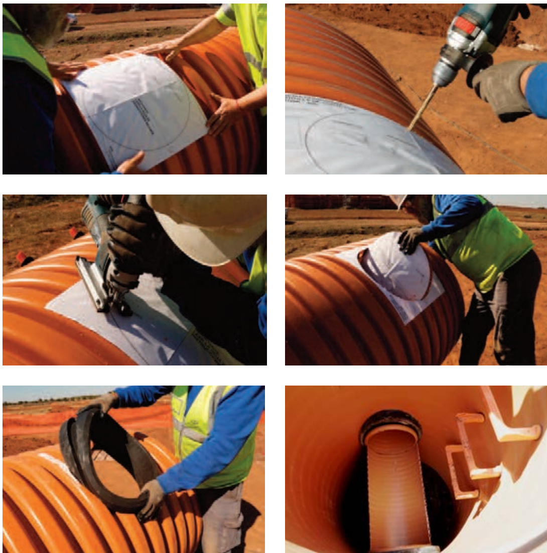
Secuencia de instalación de un clip elastomérico
