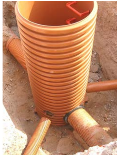
El cuerpo del pozo SANECOR® se fabrica a partir de tubería SANECOR® SN8
