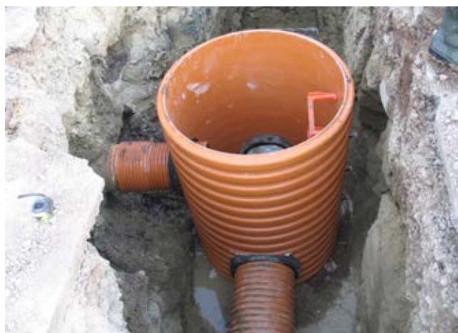
Ejecución de acometidas realizadas in situ
