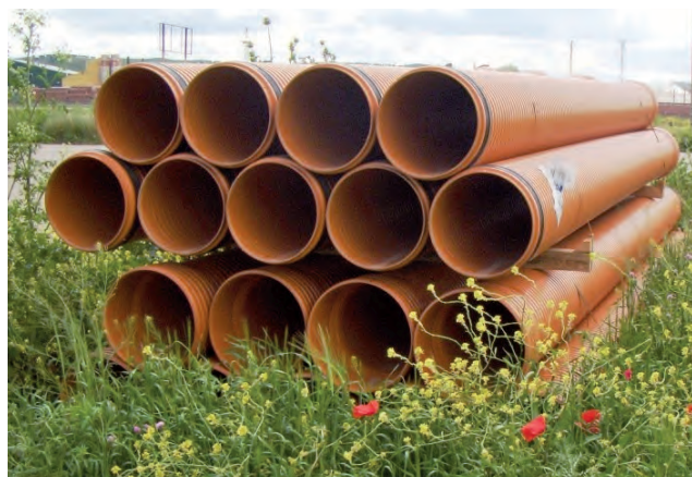
ACOPIO TUBERÍA SANECOR®.
