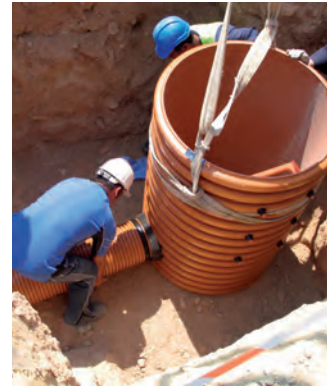
INSTALACIÓN DE TUBERÍAS AL CUERPO DEL POZO.
