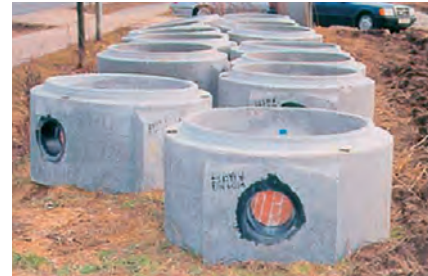
POZOS DE REGISTRO EN MATERIALES CONVENCIONALES (HORMIGÓN Y LADRILLO). A LA DERECHA, ANILLOS PREFABRICADOS DE HORMIGÓN.
