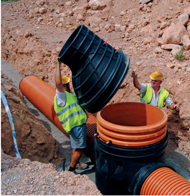
INSTALACIÓN DE PIEZA ENTRONQUE DE PASO TOTAL.
