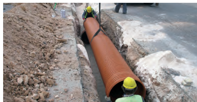
MANIPULACIÓN EN OBRA DEL TUBO SANECOR®.
