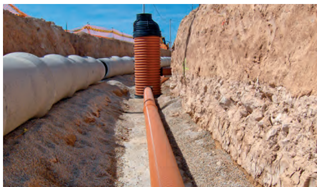
COLECTOR Y POZOS SANECOR® PARA AGUAS RESIDUALES JUNTO A COLECTOR DE PLUVIALES EN HORMIGÓN.
