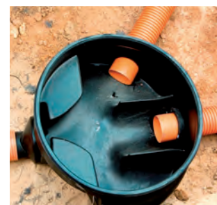
CONEXIÓN CON ELEMENTOS PLÁSTICOS PREFABRICADOS.
