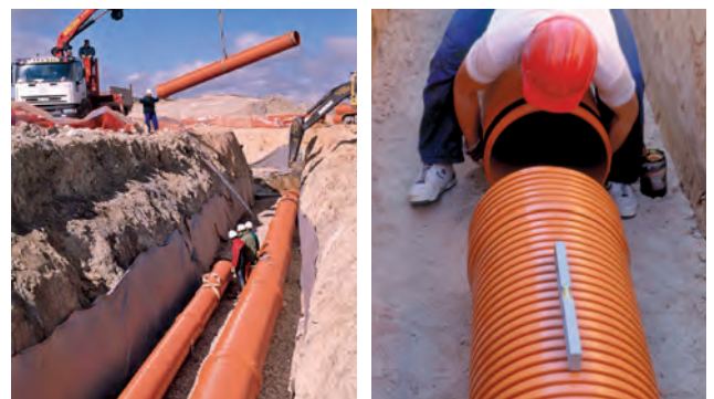
A LA IZDA., MONTAJE DE TUBERÍAS SANECOR® CON MEDIOS MECÁNICOS DISCRETOS (DIÁMETROS MEDIOS Y GRANDES). A LA DCHA., UNIÓN MANUAL (DIÁMETROS PEQUEÑOS).
