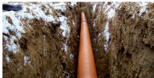
VISTA DE TUBERÍA SANECOR® INSTALADA EN LA ZANJA.
