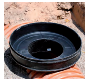
INSTALACIÓN DEL CUERPO CON BASE DE REGISTRO.
