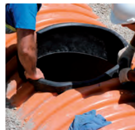
INSTALACIÓN DEL CUERPO CON BASE DE REGISTRO.
