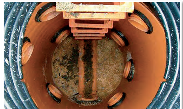
REALIZACIÓN DE MÚLTIPLES ACOMETIDAS REALIZADAS IN SITU.
