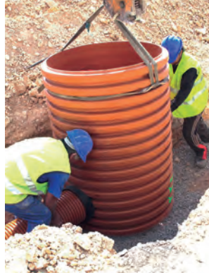
INSTALACIÓN DE TUBERÍAS AL CUERPO DEL POZO.
