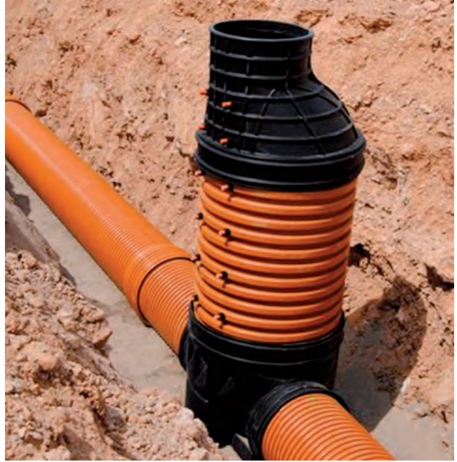
INSTALACIÓN DE PIEZA ENTRONQUE DE PASO TOTAL.
