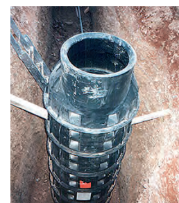
POZOS DE REGISTRO EN MATERIALES PLÁSTICOS (POLIÉSTER Y POLIETILENO).
