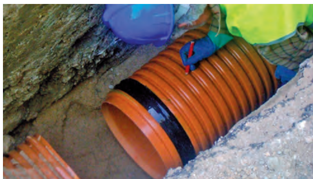
CONEXIÓN MANUAL DE TUBERÍA CORRUGADA.
