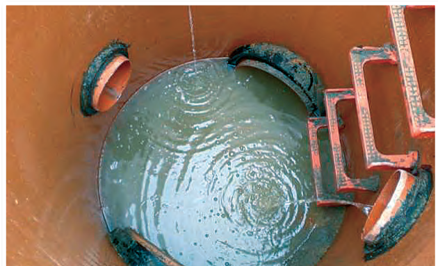
REALIZACIÓN DE MÚLTIPLES ACOMETIDAS REALIZADAS IN SITU.
