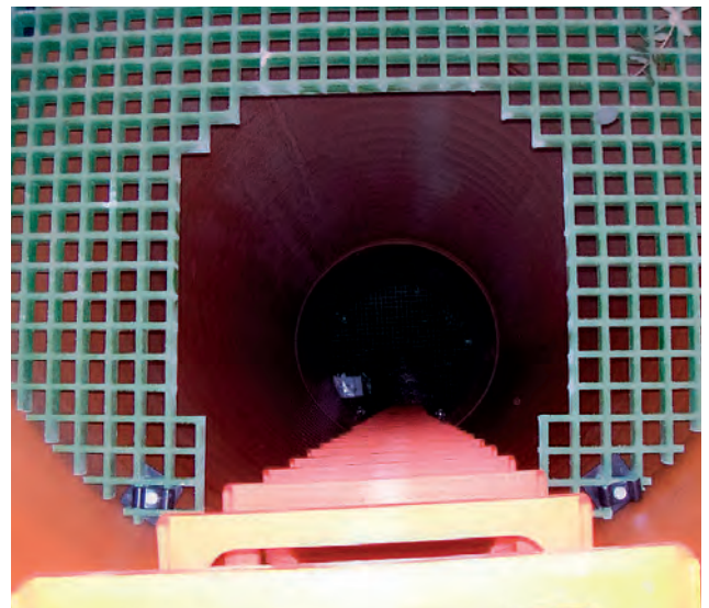
TRAMEX DE POLIÉSTER EN POZOS SANECOR®.
