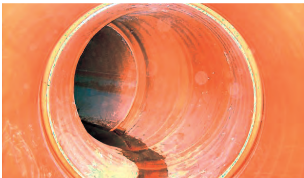
VISTA INTERIOR DE COLECTOR SANECOR® CON DESVIACIÓN ANGULAR
