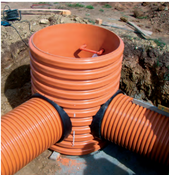
INSTALACIÓN DE POZOS EN COLECTORES CON CAMBIO DE DIRECCIÓN.
