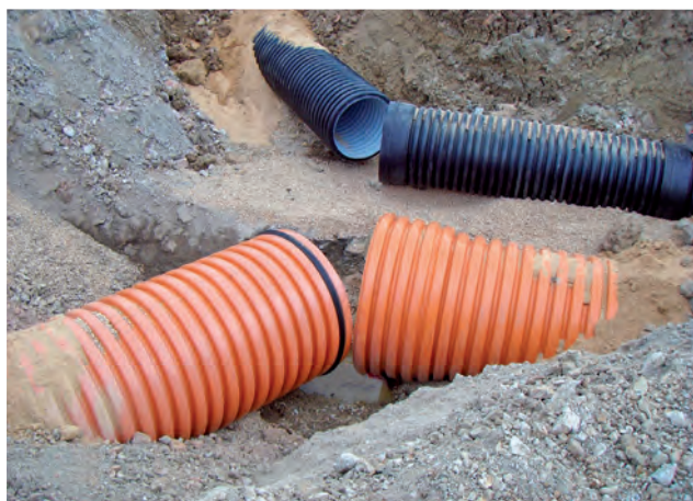
TUBERÍAS DE PVC CORRUGADO (COLOR TEJA) Y DE PE CORRUGADO (COLOR NEGRO).
