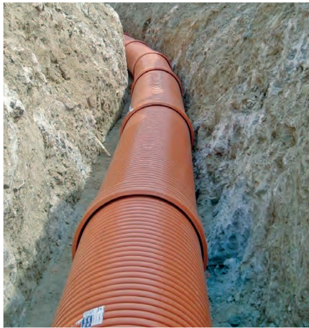
TUBERÍA SANECOR® DE 1200 mm CON DESVIACIÓN ANGULAR.
