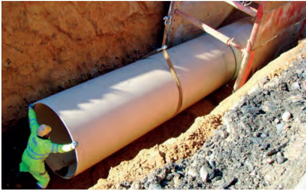
MONTAJE DE TUBOS DE PRFV EN ZANJA ENTIBADA.
