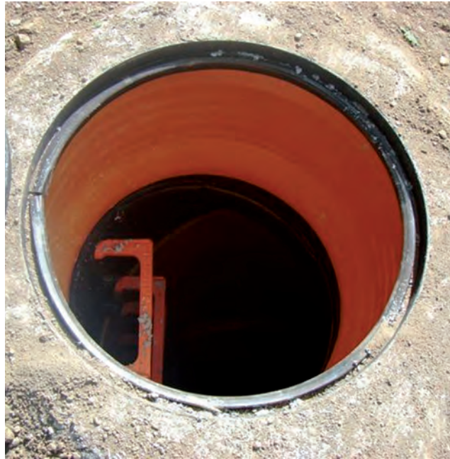
CORONACIÓN DEL POZO.
