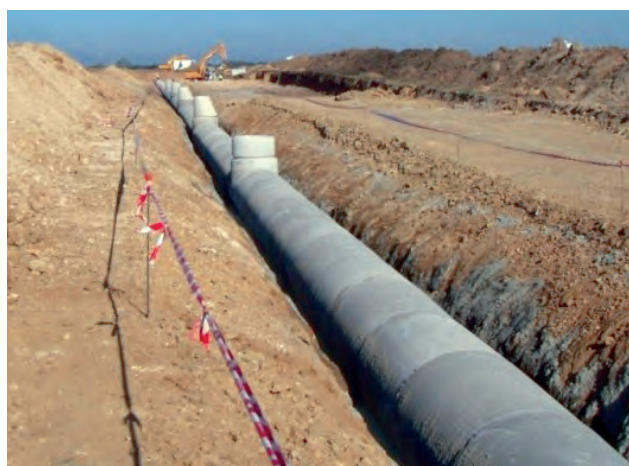
COLECTOR DE HORMIGÓN ARMADO.
