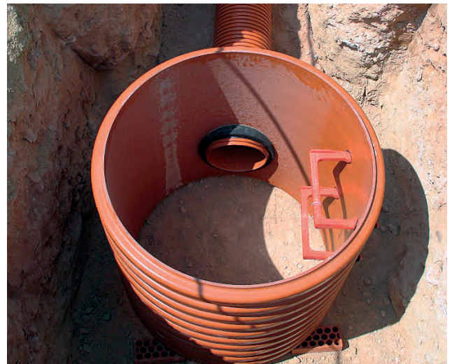
HORMIGONADO DEL FONDO DEL POZO. 1ª FASE.
