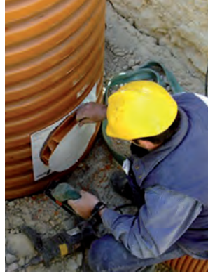
PROCEDIMIENTO DE PERFORACIÓN DE TALADROS PARA INSERCIÓN DE CLIPS ELASTOMÉRICOS.
