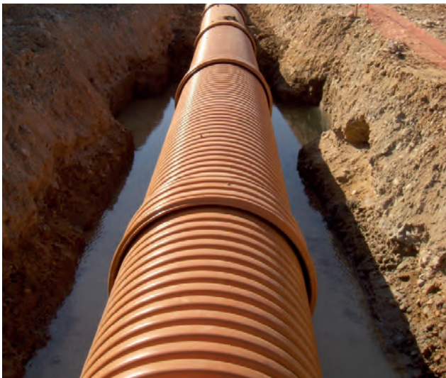
COLECTOR DE PVC CORRUGADO SN8.
