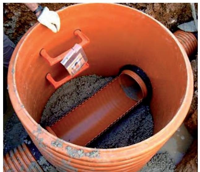
HORMIGONADO DEL FONDO DEL POZO. 2ª FASE.
