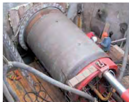
Hormigón polímero (tuberías de hinca).
