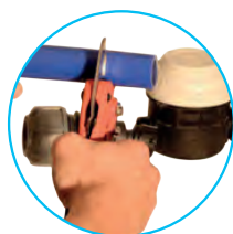
2. Cortar con un cortatubos específico.
