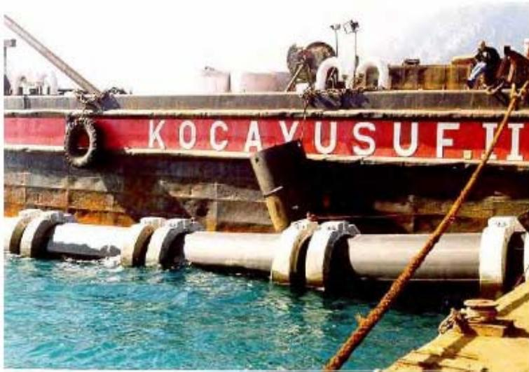
*Figura 0.2.2.2 Fijación de contrapesos de hormigón a la tubería.*
