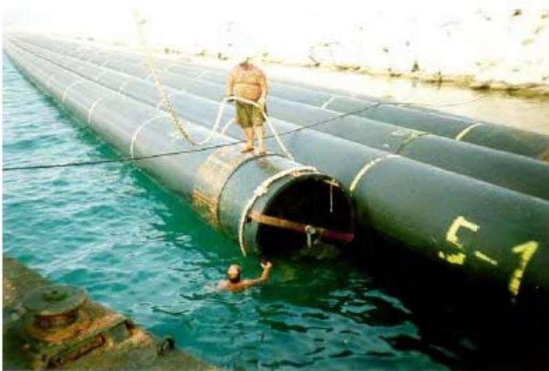
*Figura 0.2.2.1 Almacenamiento de tramos de tubería.*
