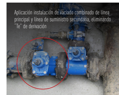
Aplicaciones que permiten la reducción de materiales y el espacio de arquetas, reduciendo ocupaciones de espacio y costes globales obra
