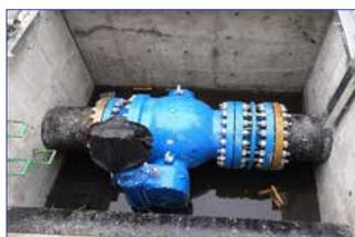
Las válvulas de esfera en las tuberías de transmisión de agua minimizan las pérdidas de presión y suponen un importante ahorro de energía, lo que garantiza el máximo caudal volumétrico en posición abierta.
