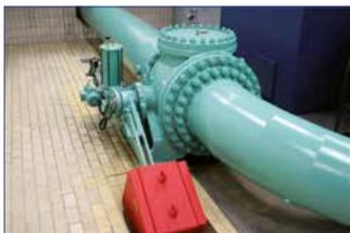
Diseño robusto de la válvula de esfera que puede soportar altas cargas dinámicas. Aquí, la entrada del agua cruda para la preparación de agua potable.
