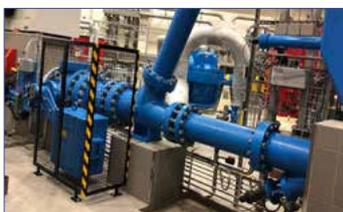
En Samina, hay 7 válvulas de esfera instaladas para una presión de funcionamiento de 83 bares en la entrada de la turbina y en las posiciones de arranque de la bomba.
