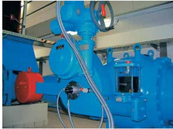
Se instaló una válvula de paso anular ERHARD en la salida de la turbina secundaria en la modernización de la central hidro-eléctrica del río Danubio. La válvula tiene un diseño especial para ser actuada por la propia energía del agua, y si se cierran las turbinas, se evitan los incrementos de presión, y se minimizan los riesgos de la instalación de una forma fiable y segura.
