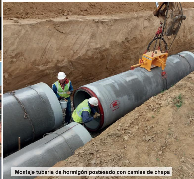
Montaje tubería de hormigón postesado con camisa de chapa
