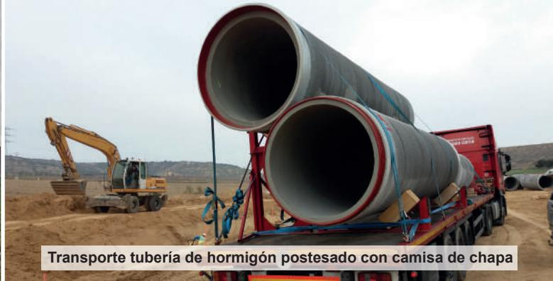
Transporte tubería de hormigón postesado con camisa de chapa
