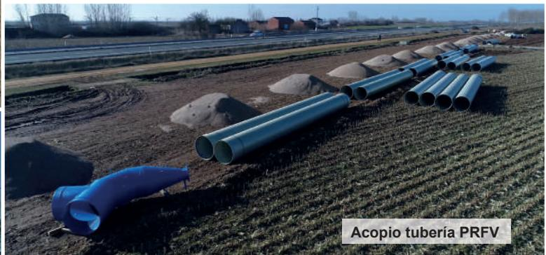
Acopio tubería PRFV
