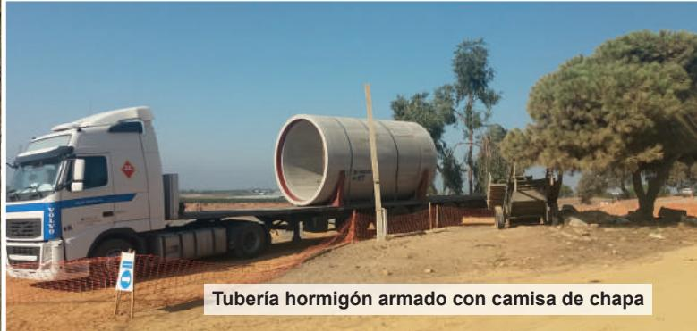
Tubería hormigón armado con camisa de chapa
