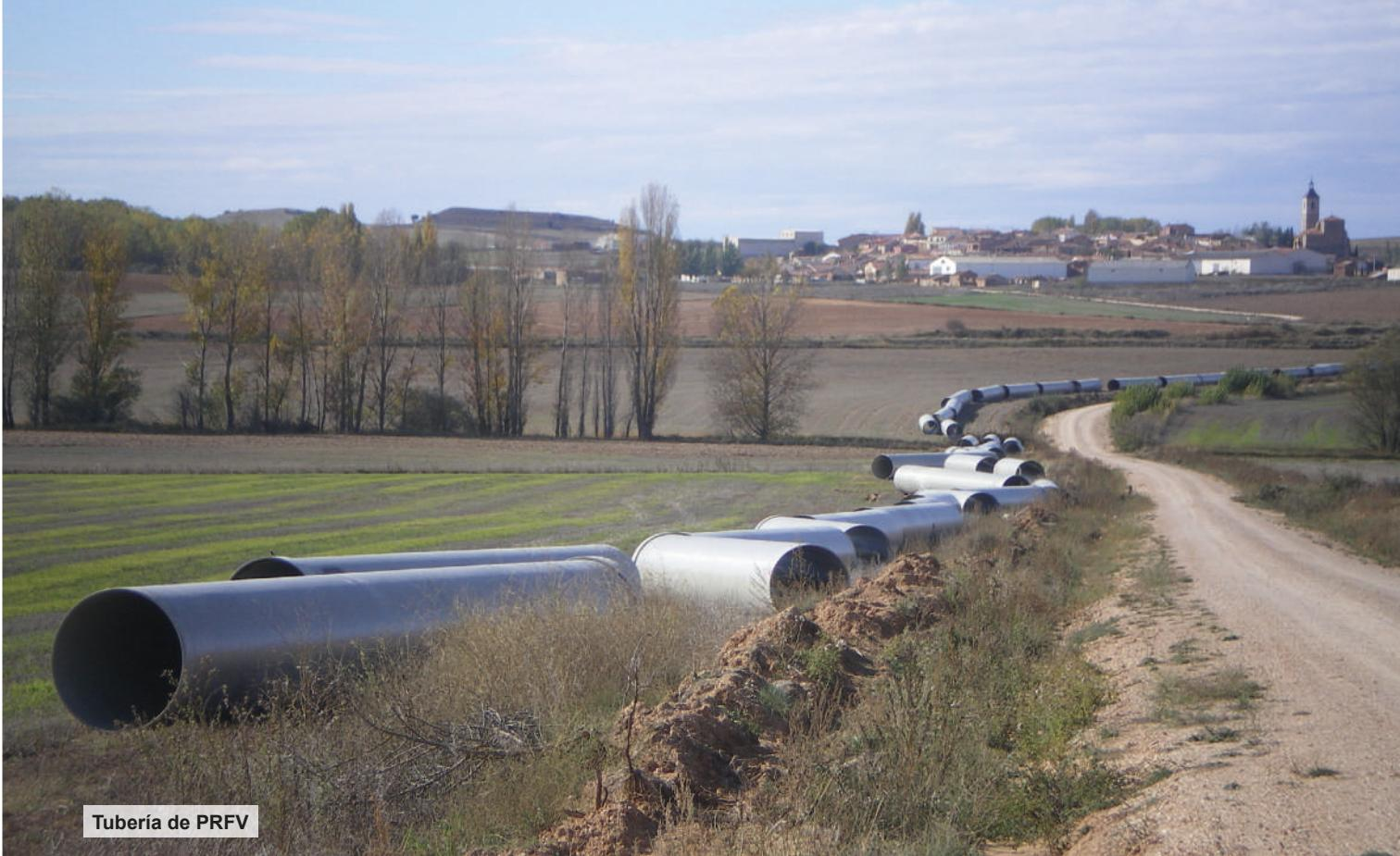
Tubería de PRFV
