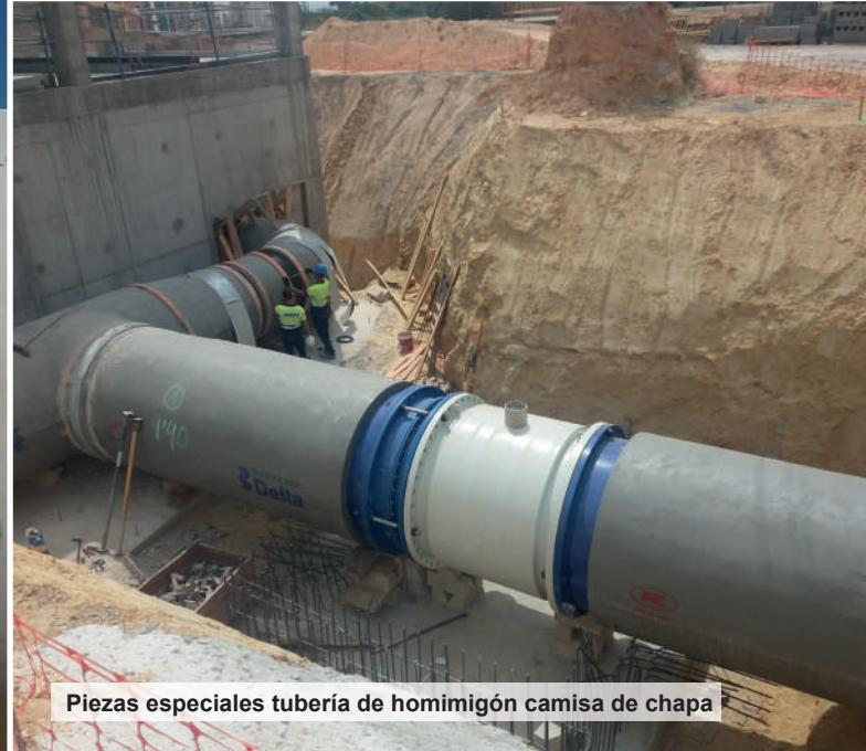
Piezas especiales tubería de hormigón camisa de chapa
