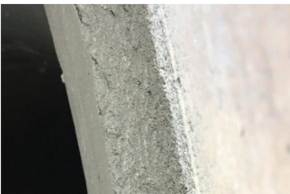
El mortero geopolímero se mezcla con agua en la superficie y es bombeado en la tubería a distancias de más de 300 metros. Una vez el mortero llega a la tubería, es proyectado por centrifugación.
