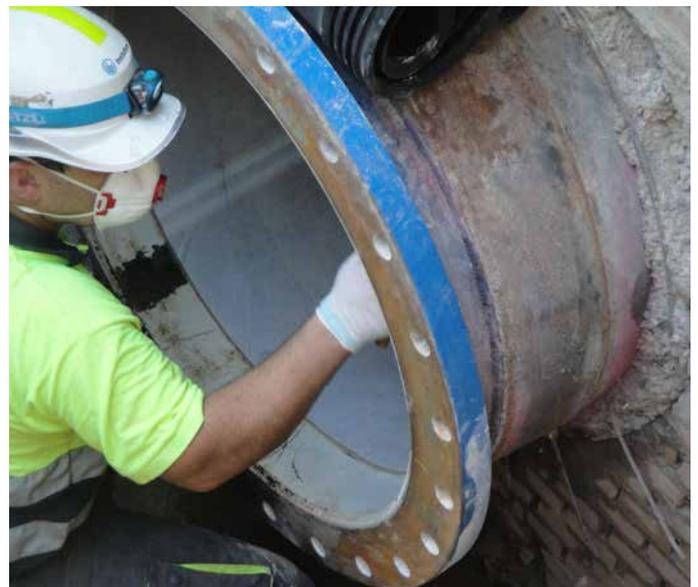
Las mangas CIPP se diseñan según la normativa ASTM F1216. La manga de presión está compuesta por distintas capas de fibra de poliéster y fibra de vidrio, impregnadas en una resina epóxico-viniléster especialmente formulada. Su cara interna está terminada con una capa delgada y lisa de polipropileno que reduce la fricción y mejora la capacidad hidráulica, además de proporcionar una barrera protectora contra la corrosión de la tubería.
