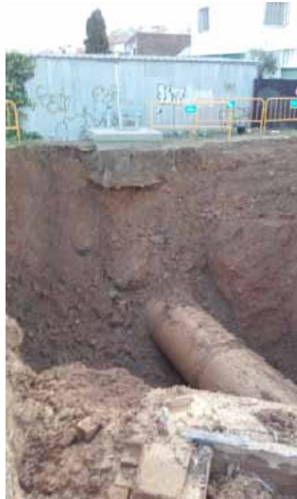
Imágenes de reparaciones en la tubería afectada
